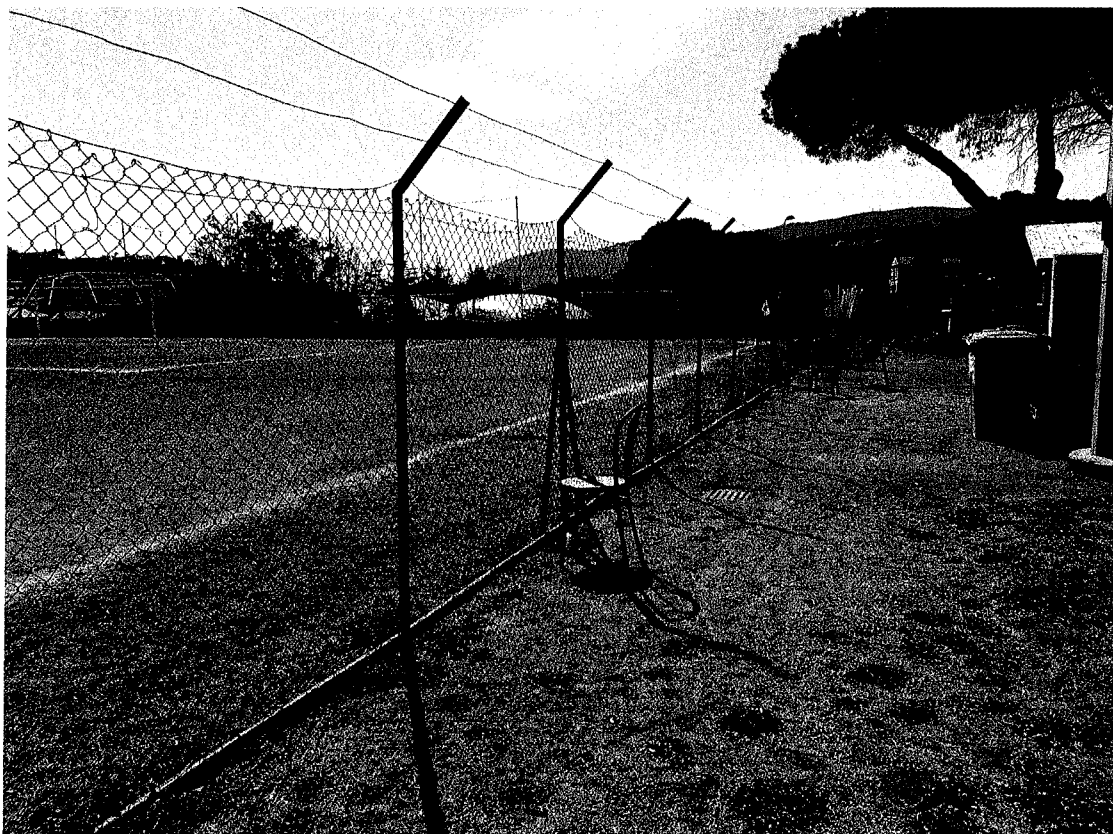
Foto n. 1 – Tratto di Recinzione da sostituire.
